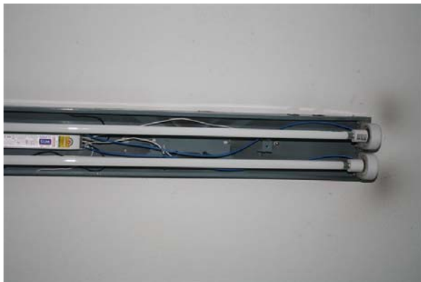
รูป 9 บัลลัสต์อิเล็กทรอนิกส์ 2x28 วัตต์ใช้ 1 ชุดสำหรับหลอด T5 ขนาด 28 วัตต์ 2 หลอด
